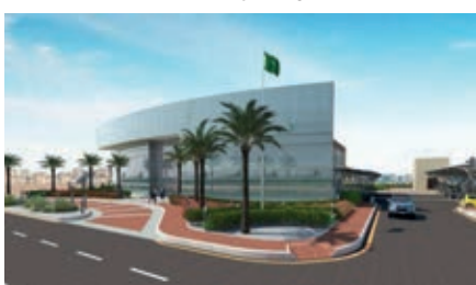
FEMCO Tower (Dammam)
