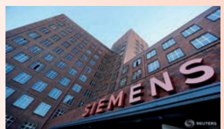
Siemens Energy (Dammam)
